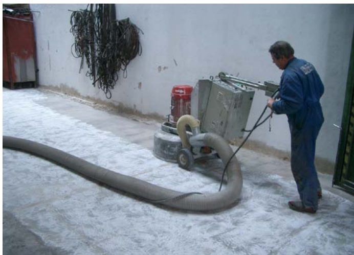
tryskání betonu
