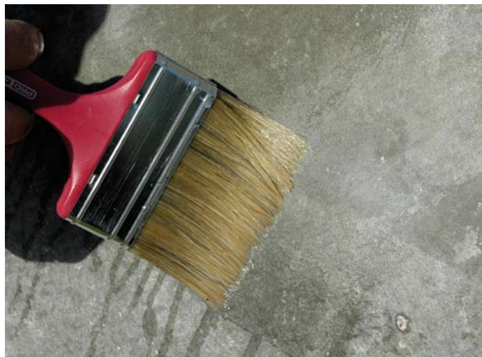
Penetrace krytiny penetračním prostředkem FORTE penetral .
