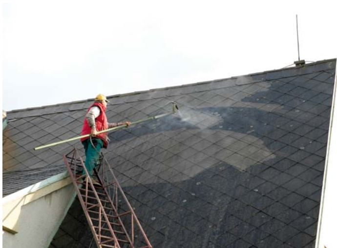
Očištění a odmaštění krytiny pomocí WAP.
